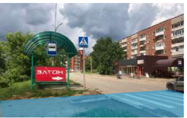
7 Отсутствие связи пешеходных переходов с тротуарами
